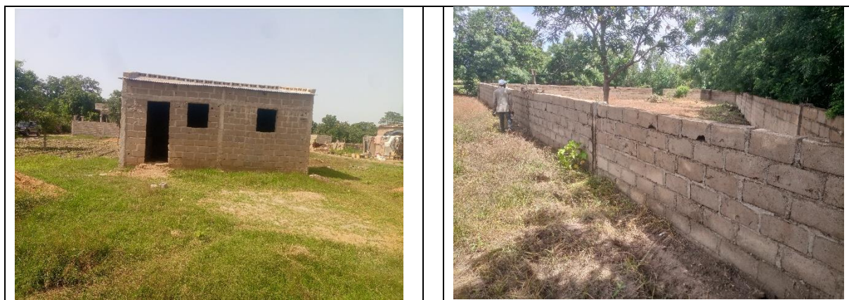
Figure 7 : Bâtis touchés sur le site STBV de Sénou (Ingerco)
